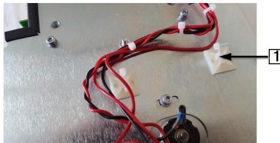
Fig. 49 Collegamento delle fascette dei cavi al processore
