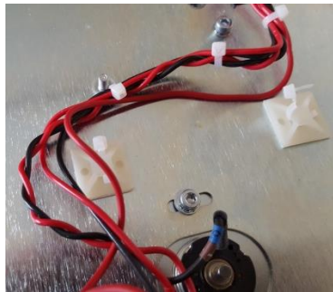
Abb. 74 : Kabelio apkabos prie kondensatoriaus
