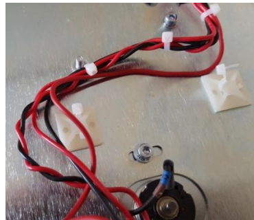
Abb. 73 : Kábeltartó a kondenzátornál
