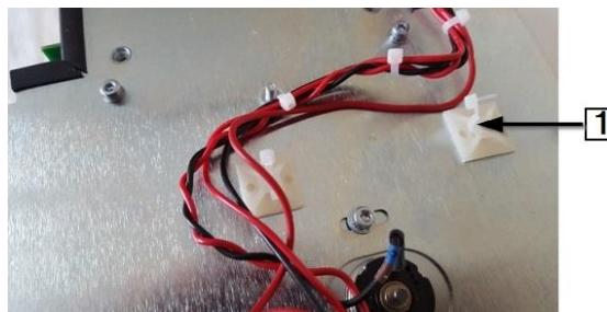
Abb 57 : Kabelbinderverbindung am Prozessor
