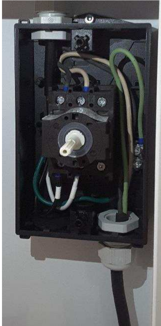
Bild 48: Strömbrytarhöljet med strömkabeln installerad
