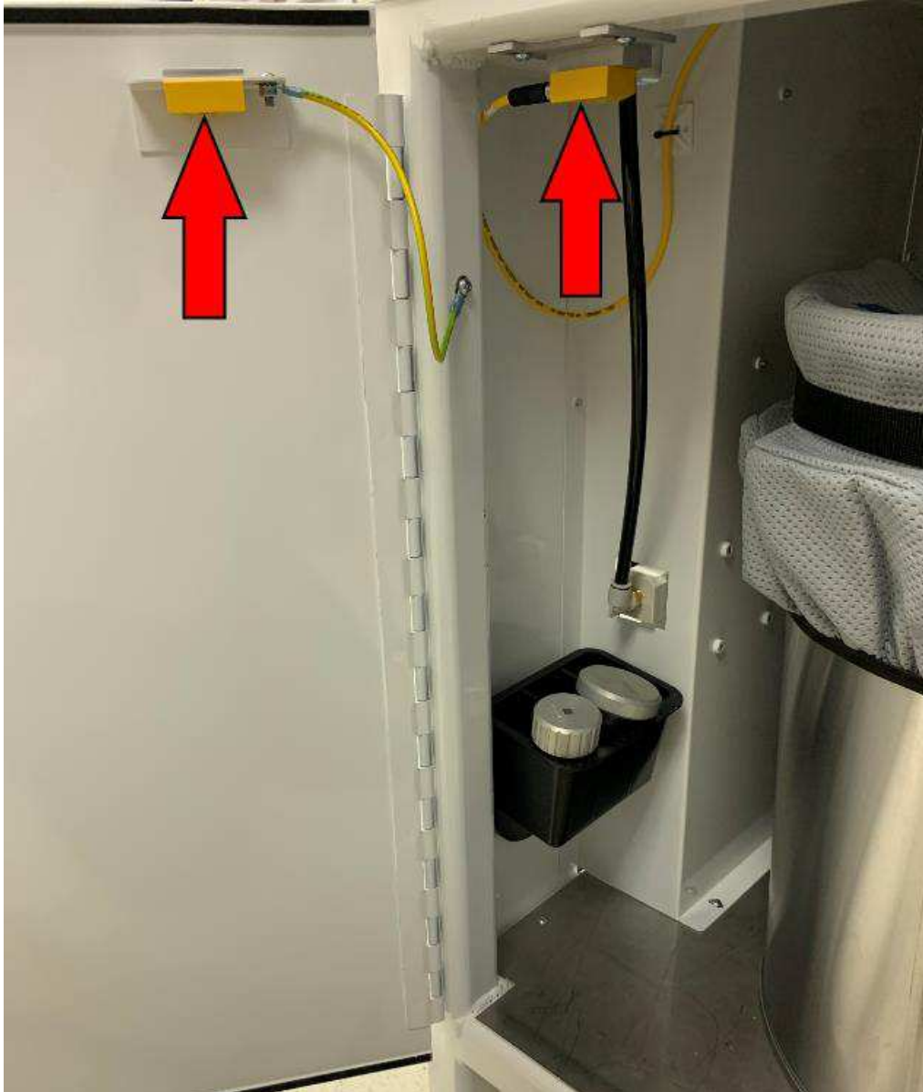
Figura 10: Dispositivo de bloqueo de seguridad de la puerta de desechos (abierto)
