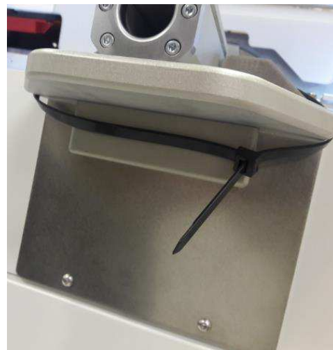
Figura 39: Túnel de cables (vista lateral)
