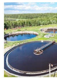
Traitement de l'eau et des eaux usées
