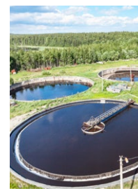
Traitement de l'eau et des eaux usées
