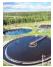
Traitement de l'eau et des eaux usées
