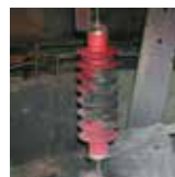
Sicheres Verhalten bei Kurzschluss
