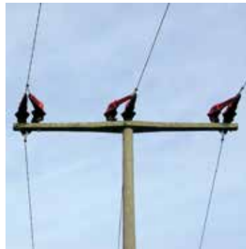
2 Hauben in paralleler Anordnung bei „doppelter Sicherheit“
