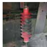
Sicheres Verhalten bei Kurzschluss
