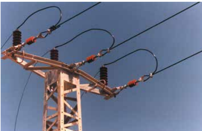
Zugisolator in Verbundbauweise
